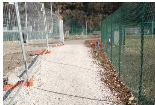
Beispiel eines "abgesicherten" provisorischen Fußgängerweges / Esempio di percorso pedonale provvisorio "protetto"
