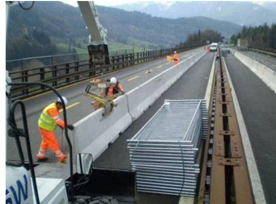
new jersey con protezione superiore piena H> 2m contro la protezione di materiale
