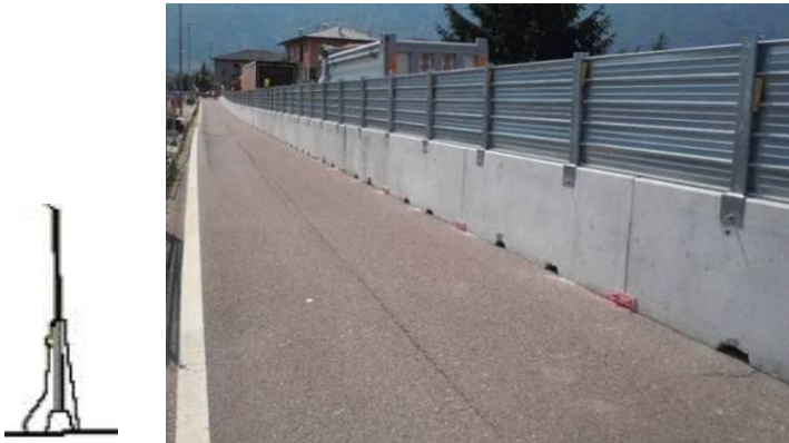
new jersey con protezione superiore piena H> 2m contro la protezione di materiale
