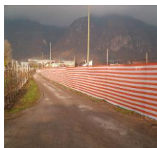
Baustahlgitter h=2m mit Schutzvorhang rete edilizia h=2 m., dotata di telo "antischeggia"
